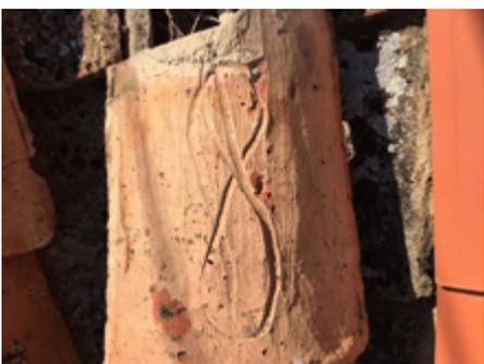
Un tejado medio de unos 55 metros cuadrados, teniendo en cuenta que se necesitan unas 25 ó 30 tejas por metro cuadrado, daría un peso total sólo en tejas de entre 3.781 y 4.537 kg. De ahí la importancia de unas buenas vigas bajo la cubierta (en el caso de que sean de madera) y que no existan goteras.
